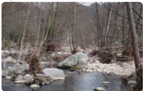
Embâcles 1 situés en amont d'une zone habitée
